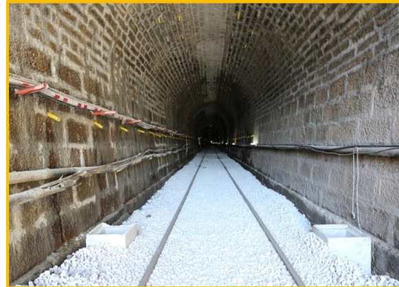
Conclusão dos trabalhos
