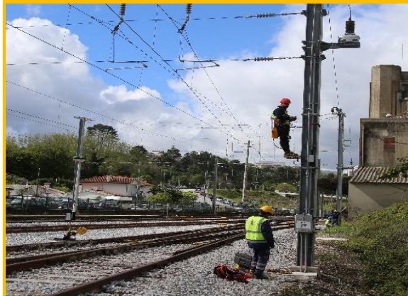
Durante os trabalhos
