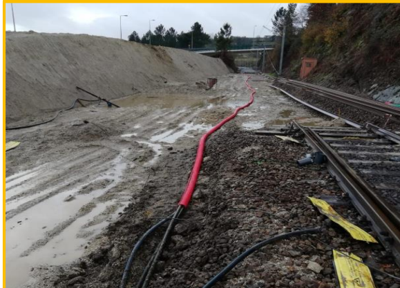
Durante os trabalhos
