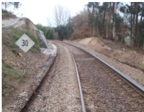
Início dos trabalhos
