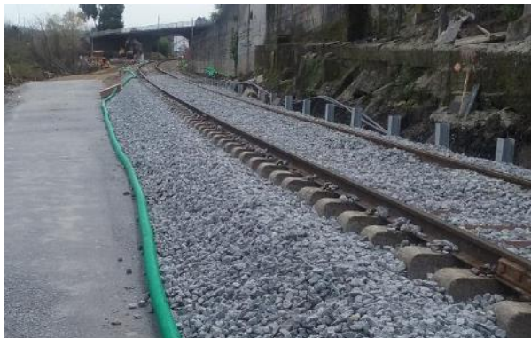
Durante os trabalhos
