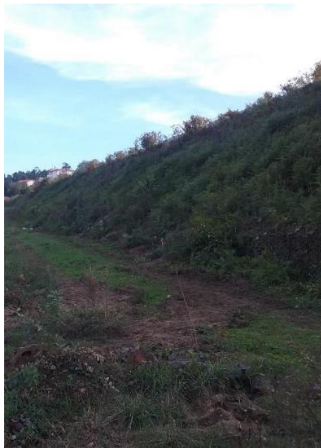
Início dos trabalhos
