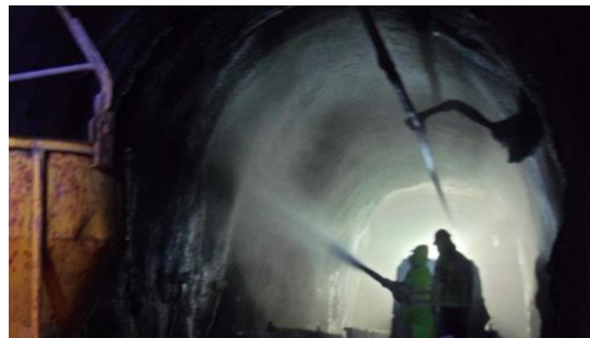
Durante os trabalhos
