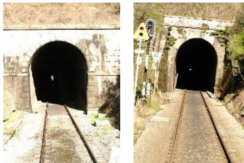
Início dos trabalhos
