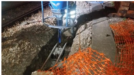
Durante os trabalhos
