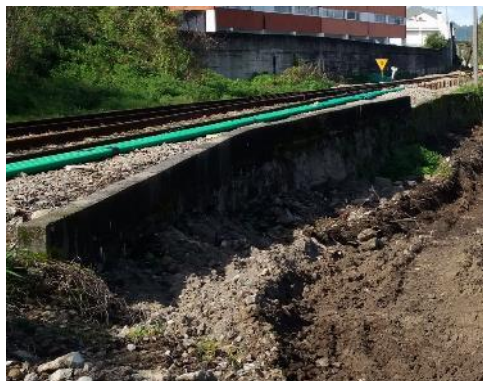
Início dos trabalhos
