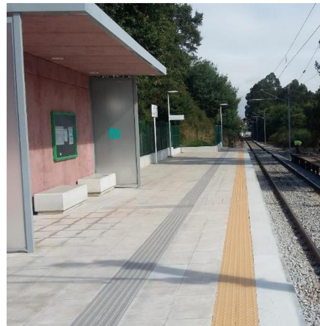
Conclusão dos trabalhos
