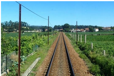
Início dos trabalhos
