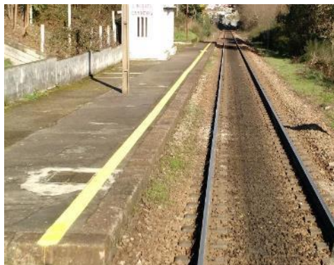
Início dos trabalhos
