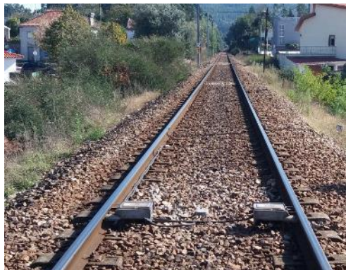
Início dos trabalhos
