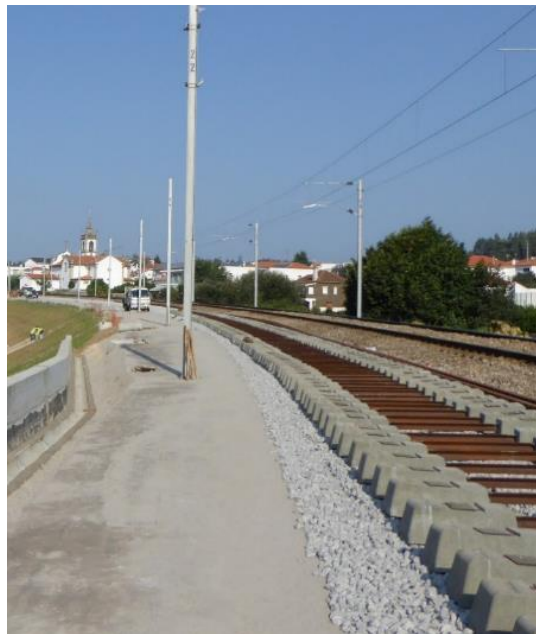
Durante os trabalhos
