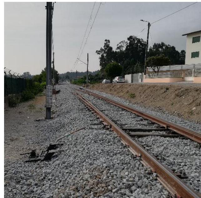
Conclusão dos trabalhos
