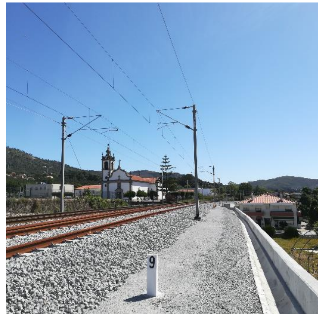
Conclusão dos trabalhos
