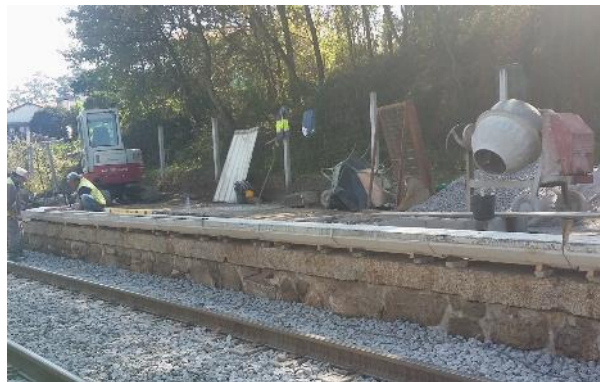
Durante os trabalhos
