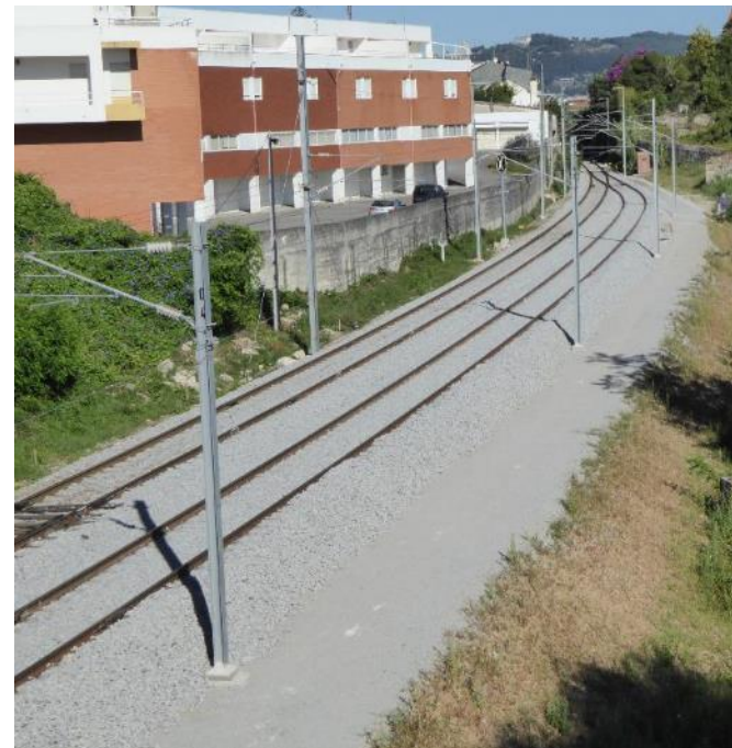
Conclusão dos trabalhos
