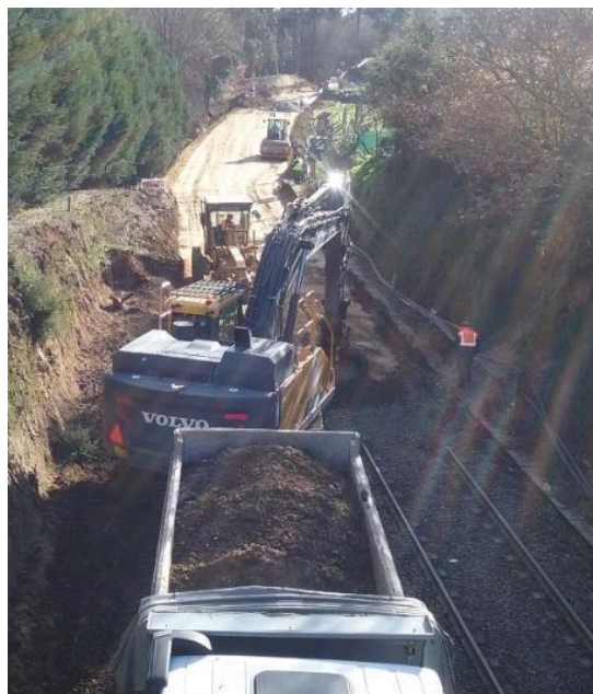
Durante os trabalhos
