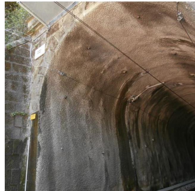
Conclusão dos trabalhos
