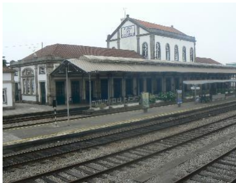
Início dos trabalhos
